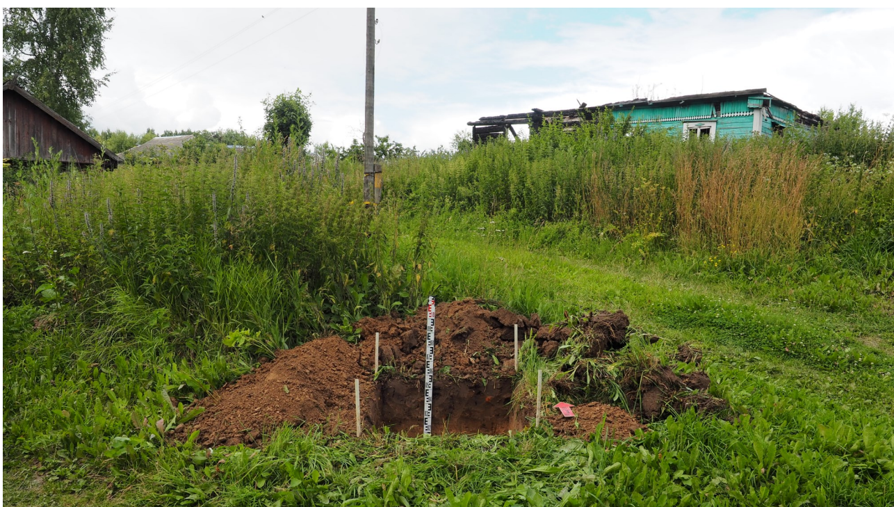
Рис. 32. Калужская область, Мещовский район. 2023 г. Археологическое обследование по объекту: «Уличные газопроводы дер. Высокое». Вид на раскопанный шурф 1 с юга.
